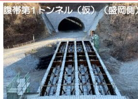
腹帯第1トンネル(仮) (盛岡側)では、掘削が完了し、覆工を行っています。全長1,774mのうち1,732mまでコンクリート打設が進んでいます。
