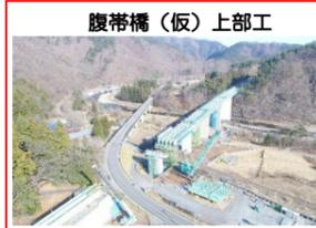
腹帯橋(仮)では、国道106号上の橋桁を架設するための段取りを行っています。
