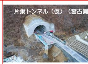
片巢トンネル(仮) (宮古側)では、覆工と坑門工の施工を行っています。全長559mのうち523mまでコンクリート打設が進んでいます。
