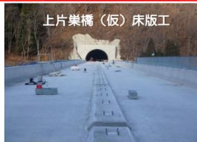
上片巢橋(仮)では、壁高欄と落下物防止柵の施工を行っています。
