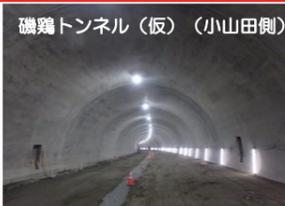
磯鶏トンネル(仮) (小山田側)では、掘削・覆工が完了しました。これから、トンネル内の舗装へ進んでいきます。
