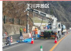
下川井地区では、標識の設置工事を行っています。現在は、標識の基礎となる部分を施工しています。
