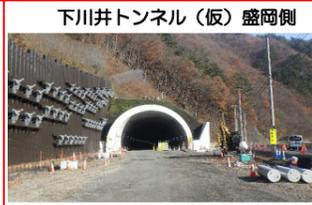
下川井トンネル(仮) (宮古側・盛岡側)では、排水構造物や電気設備等の施工を行っています。
