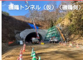
磯鶏トンネル(仮) (磯鶏側)では、坑門付近の排水構造物等の施工を行っています。
